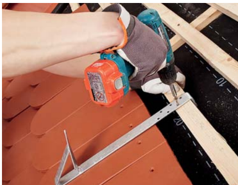
Śniegowstrzymywacze przy karpówce układanej w łuskę
