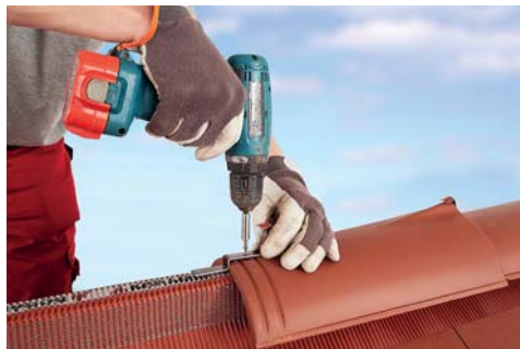
Zdj. 7. | Montaż gąsiora przy użyciu klamry
