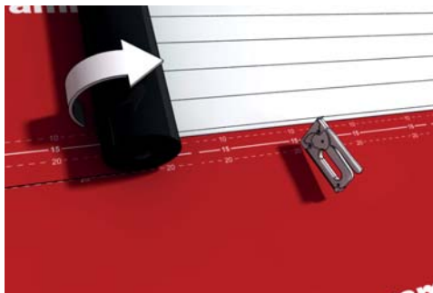
Rys. 82. | Zakład kolejnego pasa membrany
