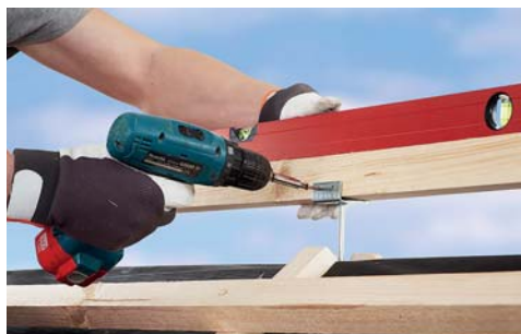
Zdj. 6. | Montaż łąty kalenicowej
