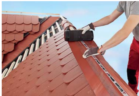
Zdj. 8. | Rozwijanie i mocowanie taśmy do łąty kalenicowej
